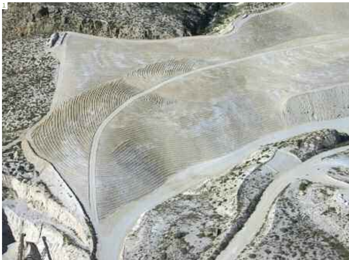
1. Προετοιμασία του εδάφους πριν τη φύτευση των νεαρών φυτών που έχουν μεγαλώσει σε φυτώρια. 2. Συλλογή γηγενών σπόρων από το γειτονικό περιβάλλον. 3. Φύτευση των δειγμάτων που μεγάλωσαν σε φυτώριο.
